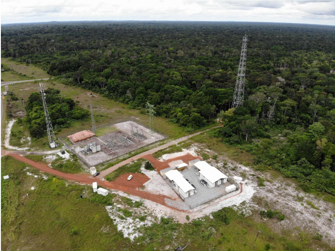
FIGURE 3 - PRISE DE VUE DRONE (DIRECTION OUEST) DU PROJET MANA ENERGIE SERVICES (NOVEMBRE 2020)
